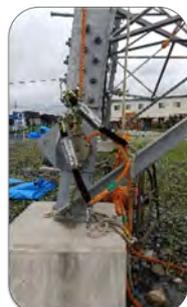
**キーロック方式とは**安全帯に装着したキーロック本体に、あらかじめ作業上に配置した安全ロープを次々と連結して移動及び作業を行う方式で、常に1本以上の安全ロープで身体を保持するもので、キーロックを取り外すためにはマスターキーで取り外すか、安全帯そのもの取り外すしか方法がない為、転落事故が防止できる。
